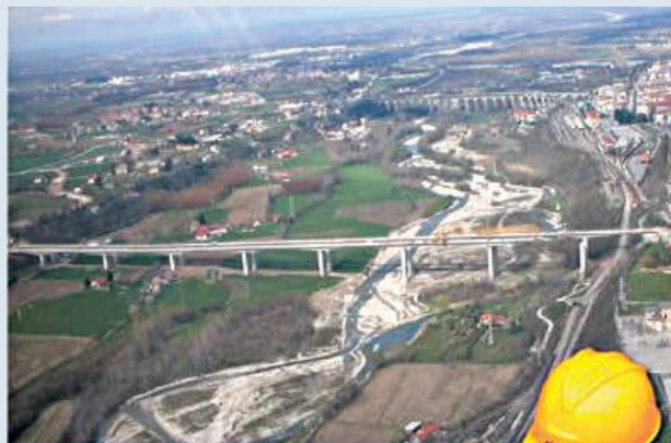
Cuneo, collegamento stradale cittadino est-ovest
